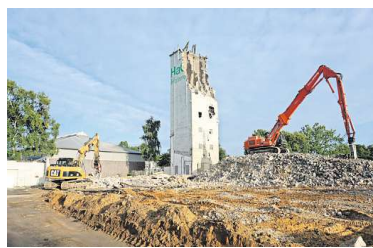
Bereits im vergangenen Jahr wurden die Gebäude auf dem ehemaligen HaGe-Gelände, darunter ein hoher Turm, abgerissen, um den Weg für die neue Bebauung in der Dorfmitte freizumachen. FOTO: KLAUS-ULRICH TÖDTER
