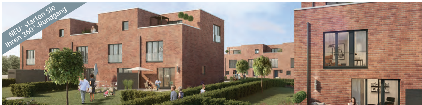
Fischbeker Heidbrook: Fish33, Reihenhäuser & Doppelhaushälften
