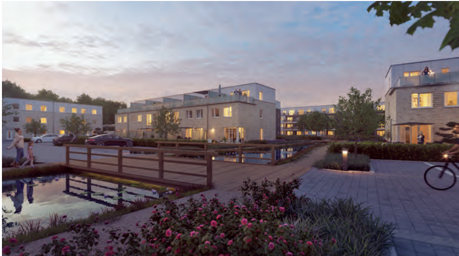
Uetersen: Rosengärten, Reihenhäuser und Eigentumswohnungen
